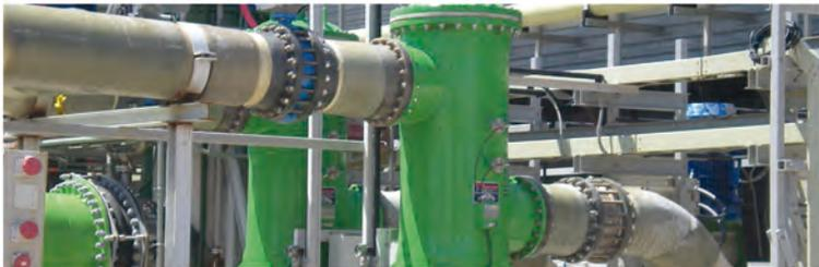
Telesá filtračných zariadení je možné vyrobiť z uhlíkových a nerezových ocelí alebo plastových a kompozitných materiálov v kombinácii s nerezovou oceľou.
